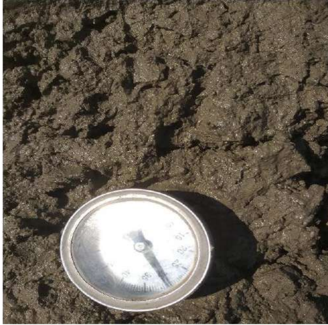
TEMPERATURA DEL CONCRETO FRESCO
