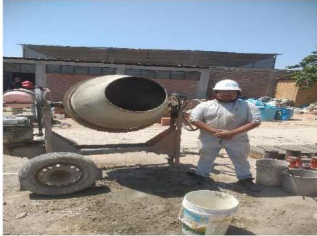
PROCESO DE ELABORACIÓN DE LAS MUESTRAS DE CONCRETO
