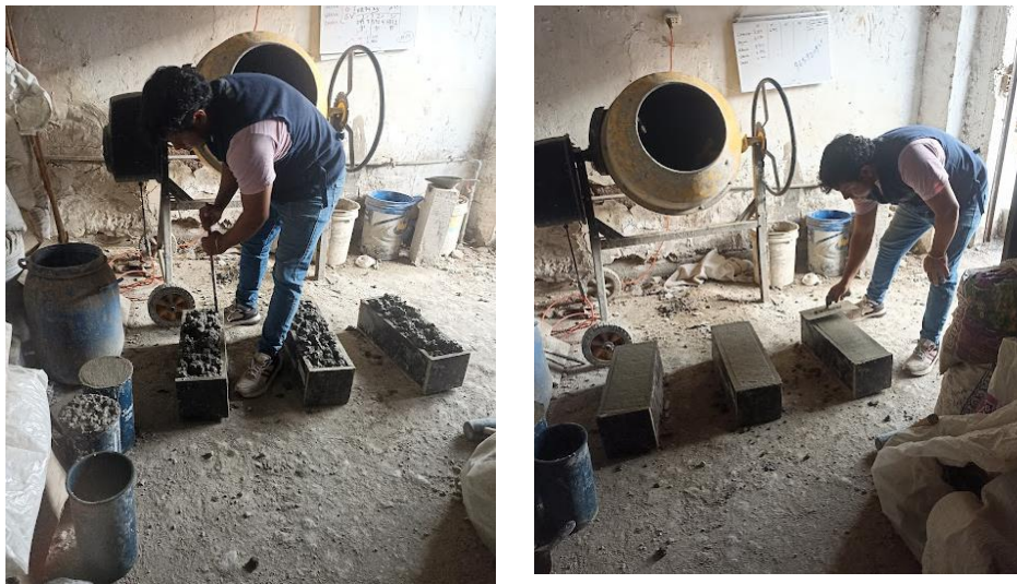
Vaciado de mezclas de concreto
