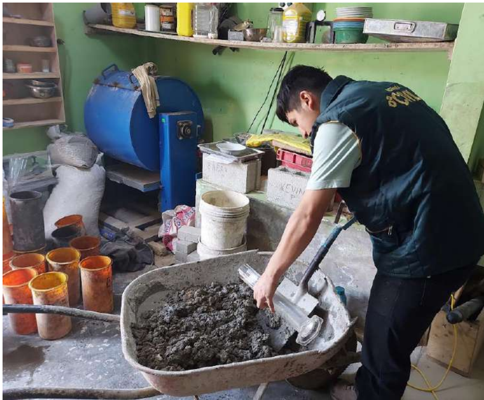
Fotografía 5. Diseño de mezcla de concreto
