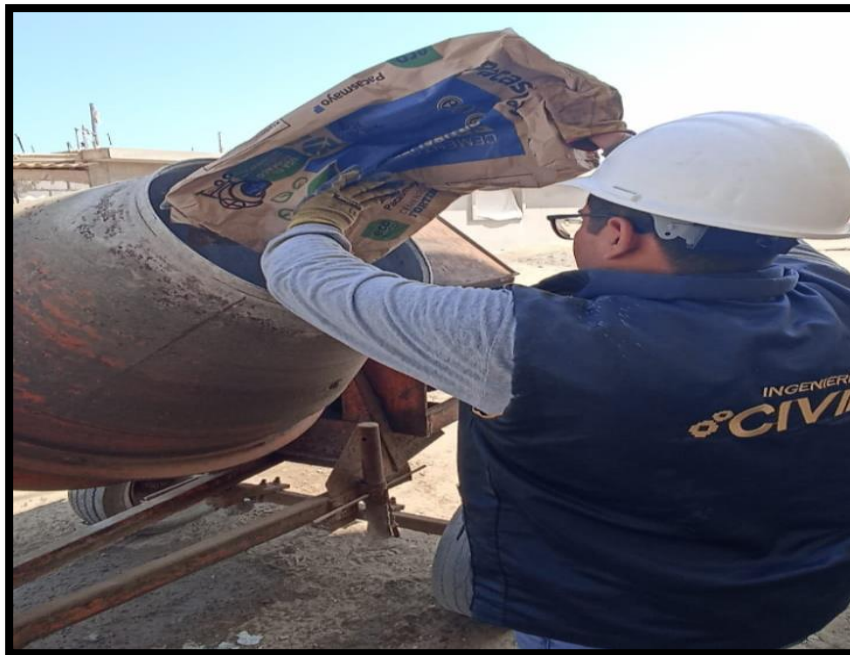
Fig. 26. Mezclado de los materiales en el trompo mezclador
