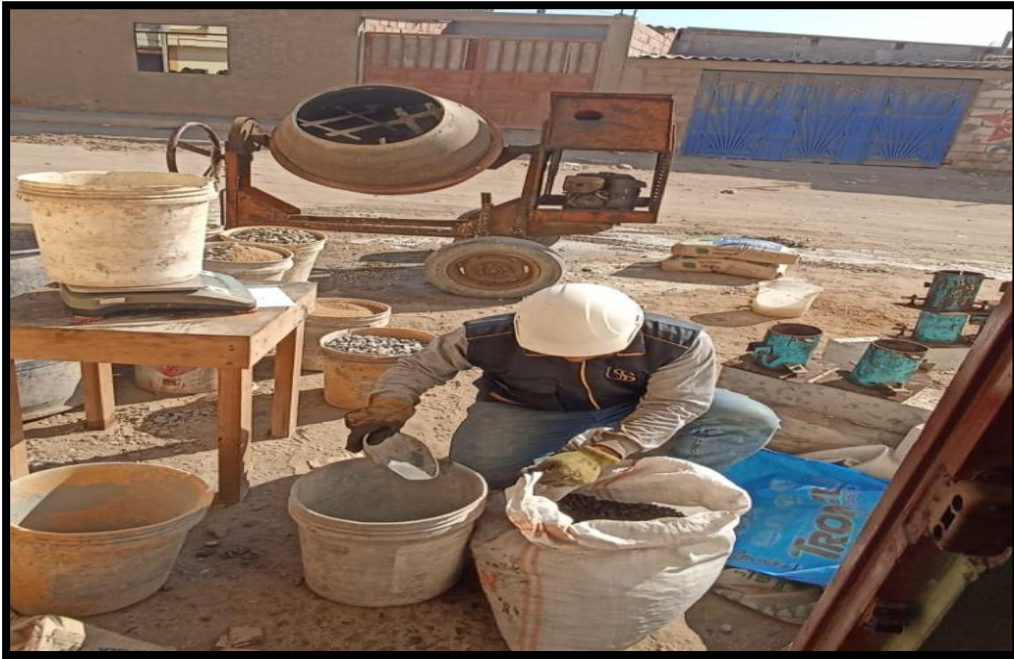
Fig. 25. Preparación según las dosificaciones de los materiales para la mezcla de concreto f'c=210\text{kg/cm}^2
