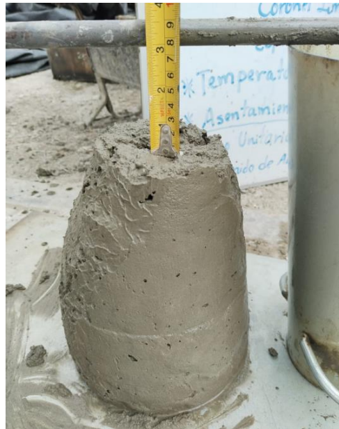
Fotografía 36 y 37. Ensayo de slump al concreto fresco
