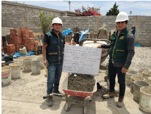
Fig. 9. Ensayo de temperatura.
