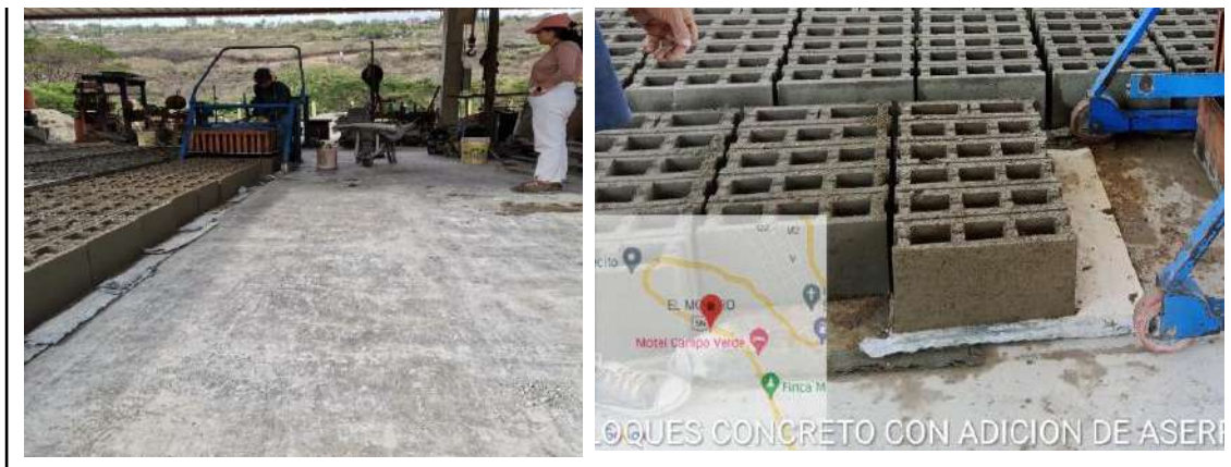
Fig 56 Elaboracion y fraguado de bloques de concreto.
