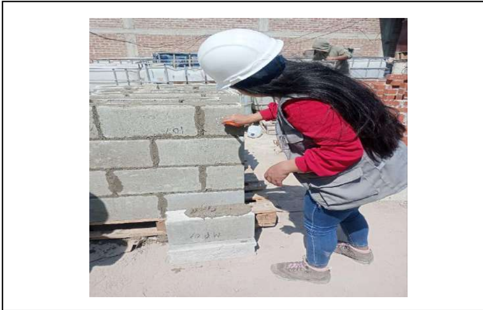
Fig 86 Construcción de muretes con bloques.
