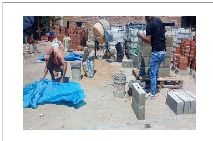
Fig 77 Construcción de pilas de albañilería con bloques de concreto.
