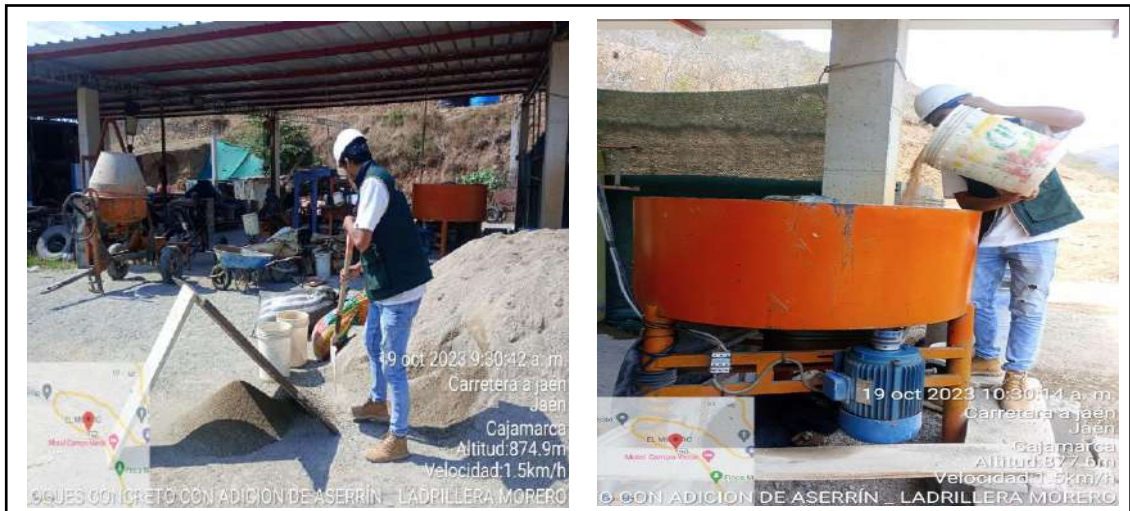
Fig 53 Preparación de la mezcla de concreto.
