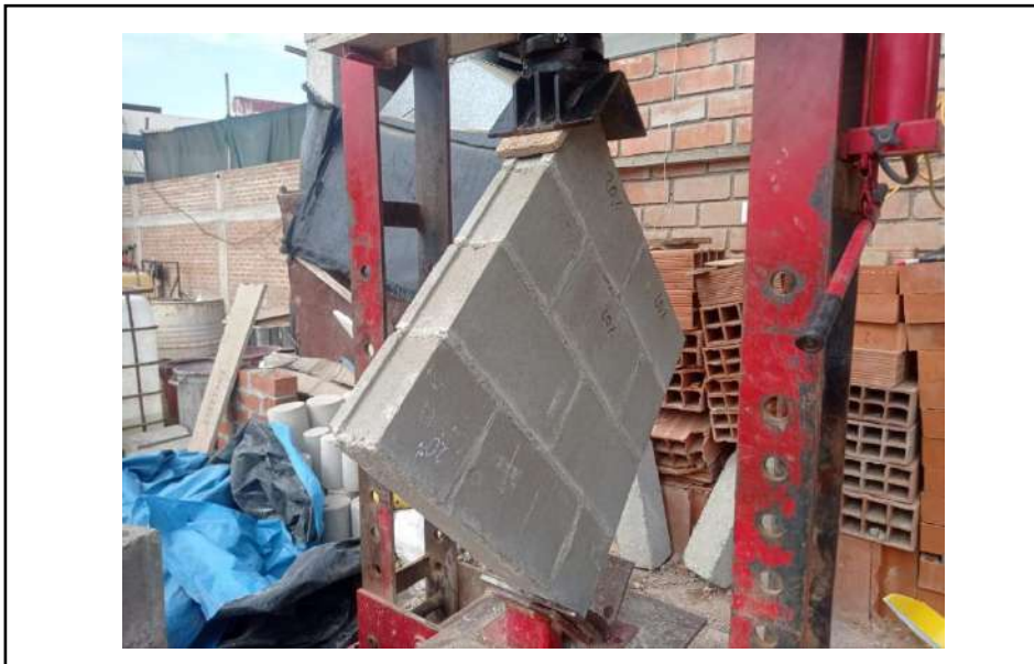
Fig 89 Ensayo de compresión diagonal en muretes.
