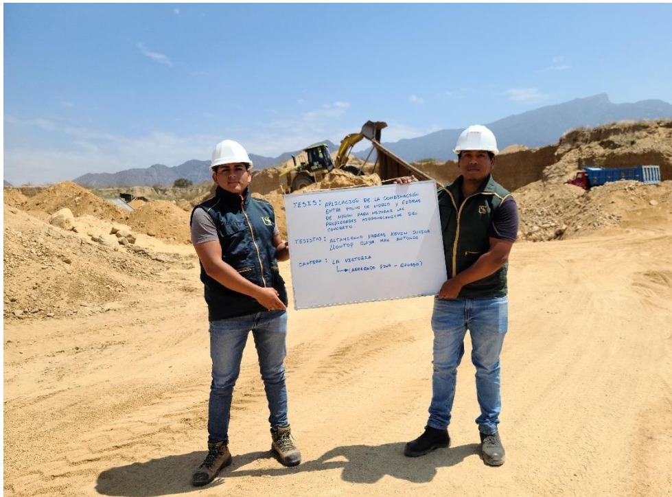
Ilustración 1. Visita a Cantera La Victoria
