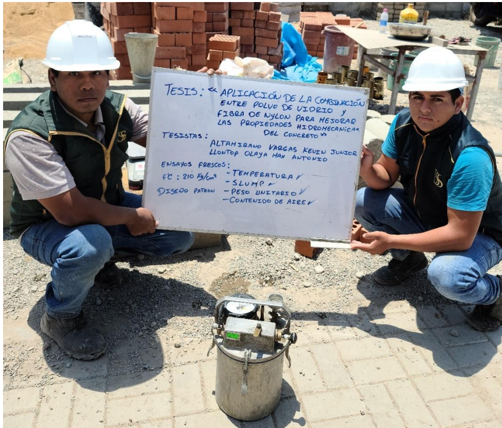
Ilustración 11. Ensayo de Contenido de aire f'c = 210 kg/cm 2
