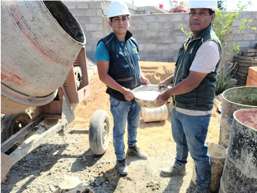
Ilustración 7. Aplicación de polvo de vidrio en mezcla de concreto
