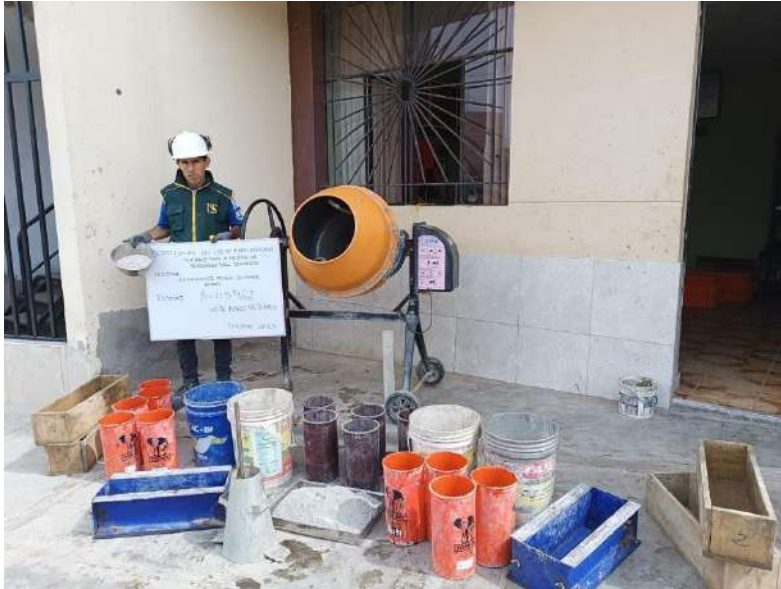
Materiales para realizar la mezcla de concreto
