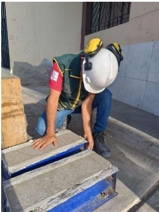
Desenformado de vigas
