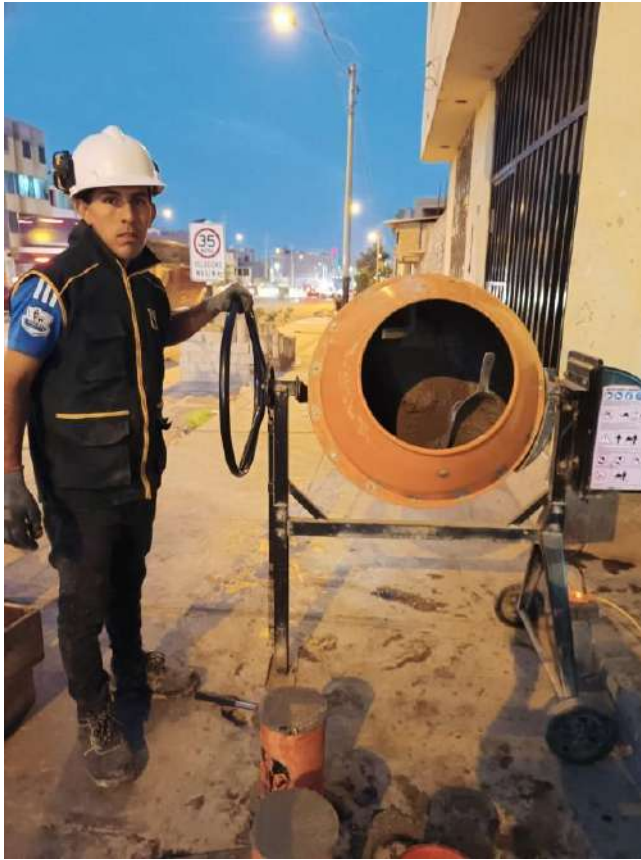
Realizando la mezcla de concreto patrón
