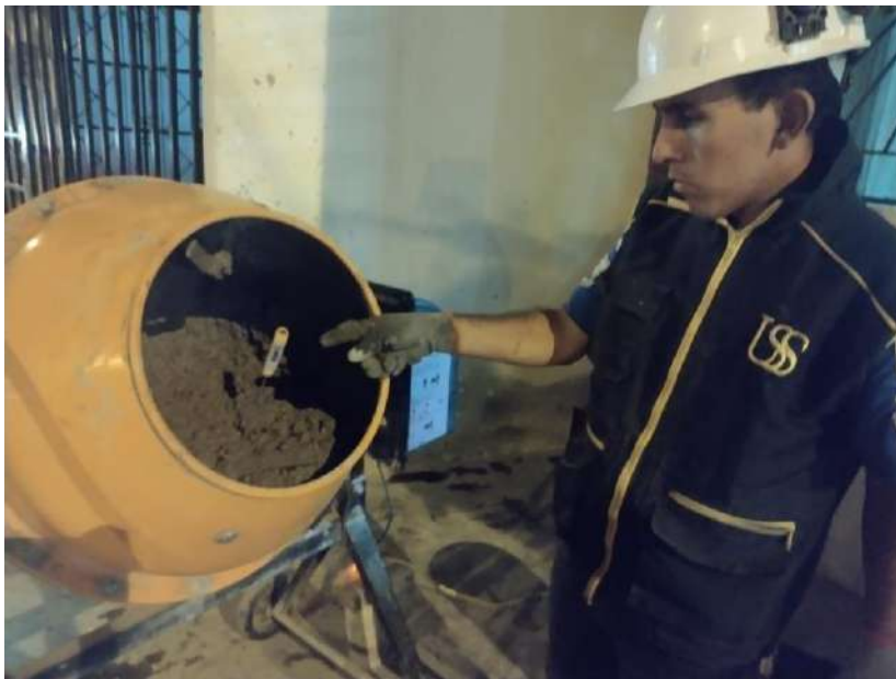
Realizando la mezcla de concreto patrón
