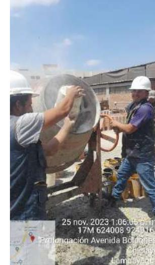
Fig.6. Incorporación de materiales a la mezcladora de concreto.
