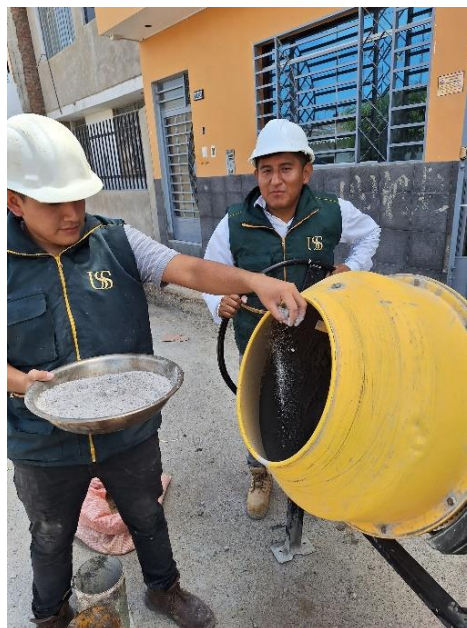
Fotografía 06. Vaciado de probetas
