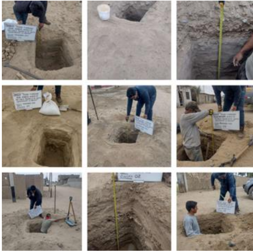
Foto: Realización de calicatas.
