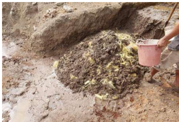
Fig. 6 Mesclado del suelo con pajilla y fibra de cabuya
