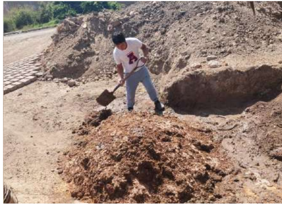
Fig. 5 Suelo seleccionado para elaboración de adobe
