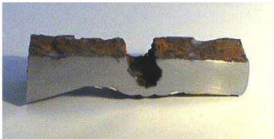
FIGURA1. 10 Corrosión de soldadura preferencial de tubería en medios que contienen CO2 [13].
