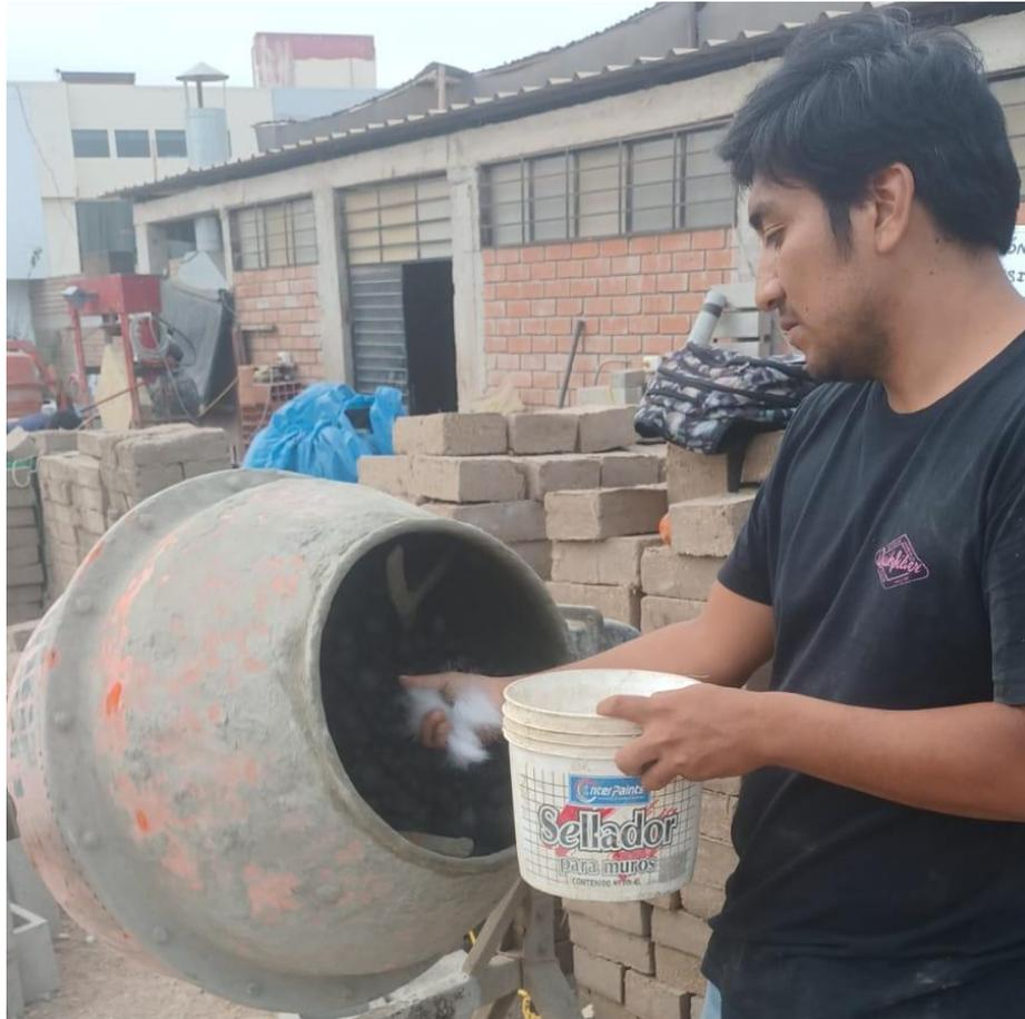
Fotografía 3: Incorporación de fibra de polipropileno a la mezcla de concreto
