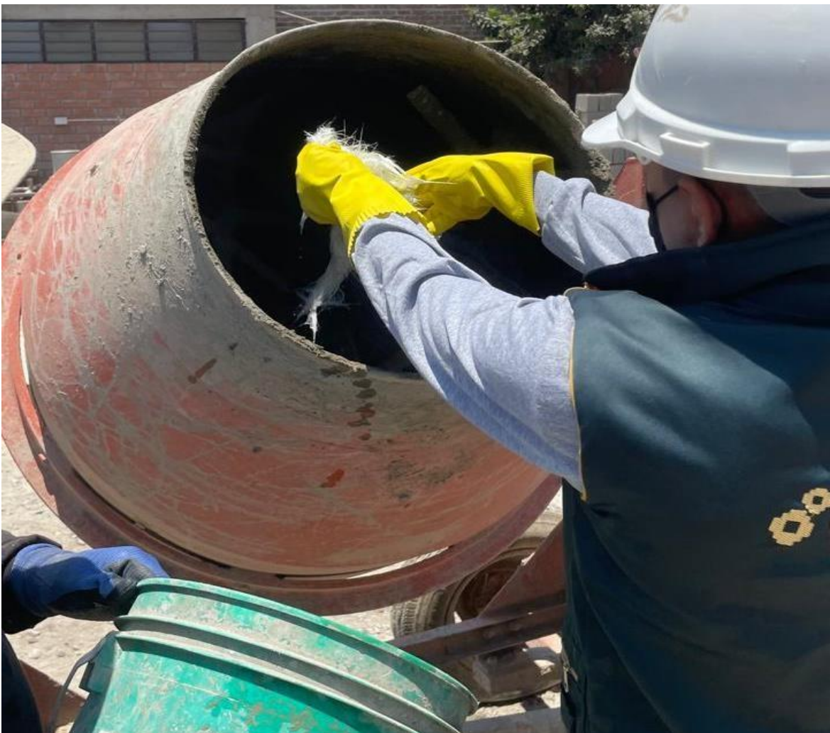
Fig. a1. Colocación de la FV a la mezcla de concreto patrón.
