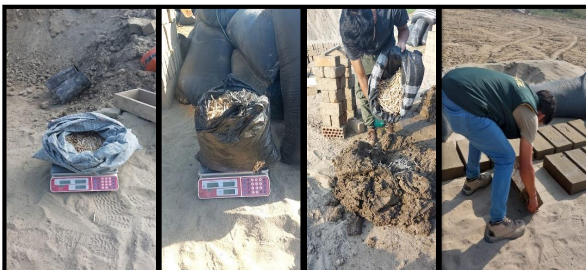
Fig.23. Proceso de elaboración de las unidades de adobe.
