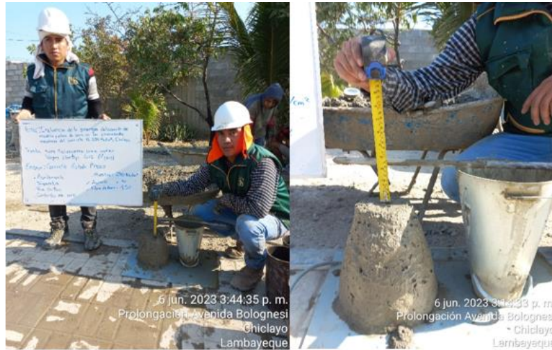
Fig.22. Ensayo del asentamiento del concreto recién elaborado
