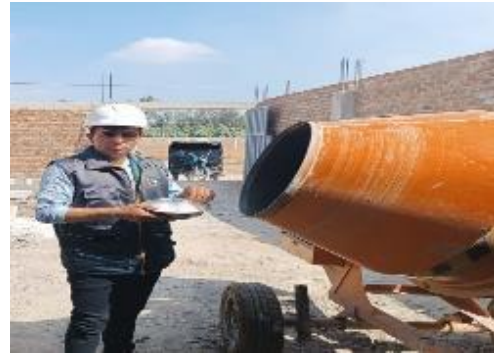
Fotografía 06: Mezcla de concreto con polipropileno y de fibra de cabuya.
