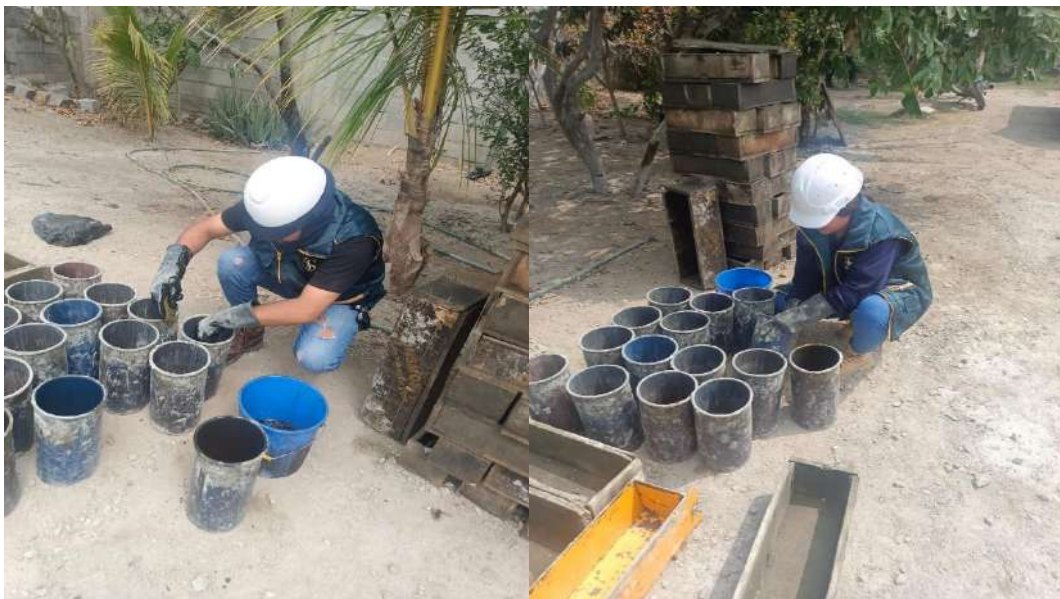
Fig. 47 Aplicación de aceite quemado a la superficie interior de los moldes
