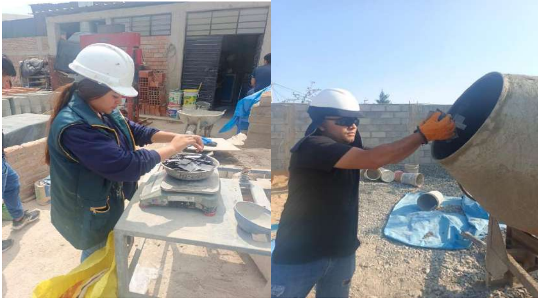
Fig. 48 Realización de la mezcla de concreto con Fibra de Acero
