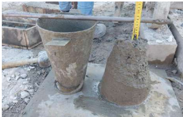
Fig. 10. Asentamiento del Concreto.
