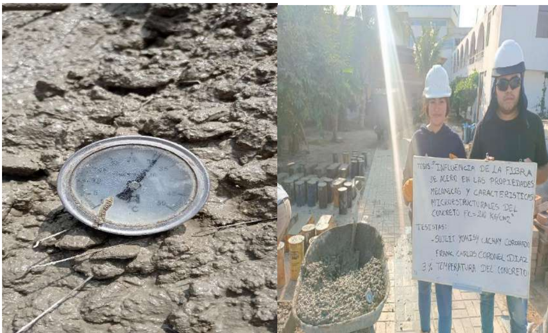
Fig. 51 Ensayo de temperatura del concreto fresco.
