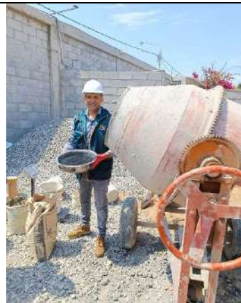
11) Aplicación del caucho granulado a la mezcla
