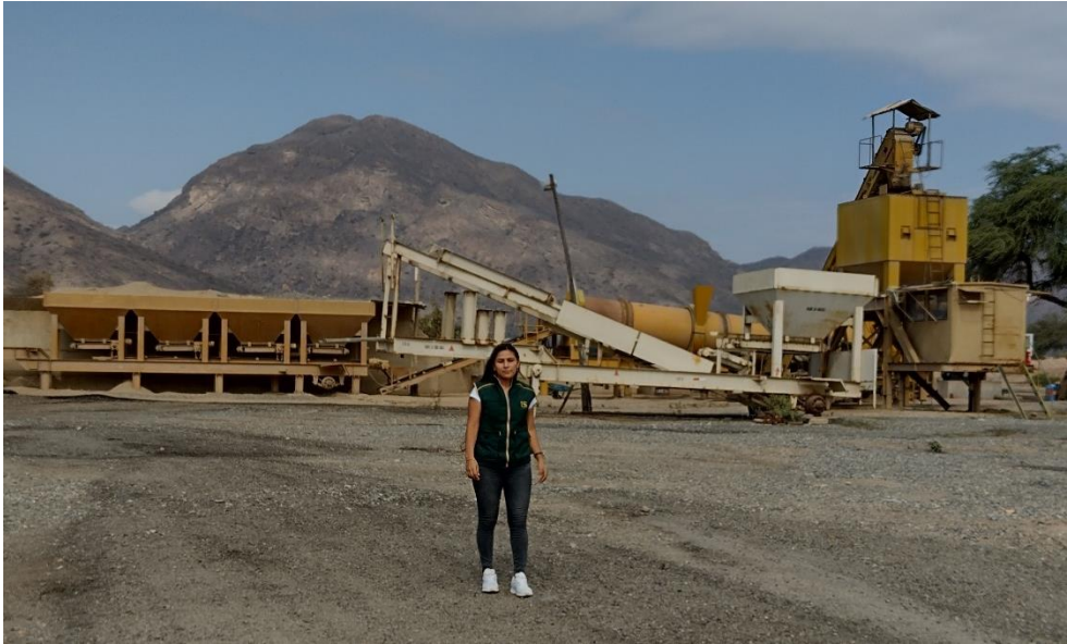
Ilustración 1. Visita Planta de Asfalto del Gobierno Regional Lambayeque
