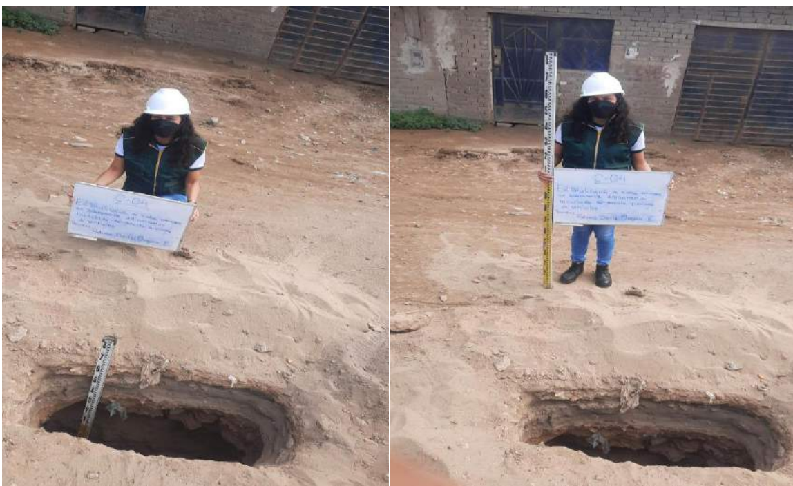
Fig. 23. Obtención de muestras de suelo de la calicata 03.
