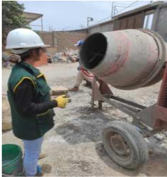
**Fotografía 10.** Elaboración del concreto en el trompo
