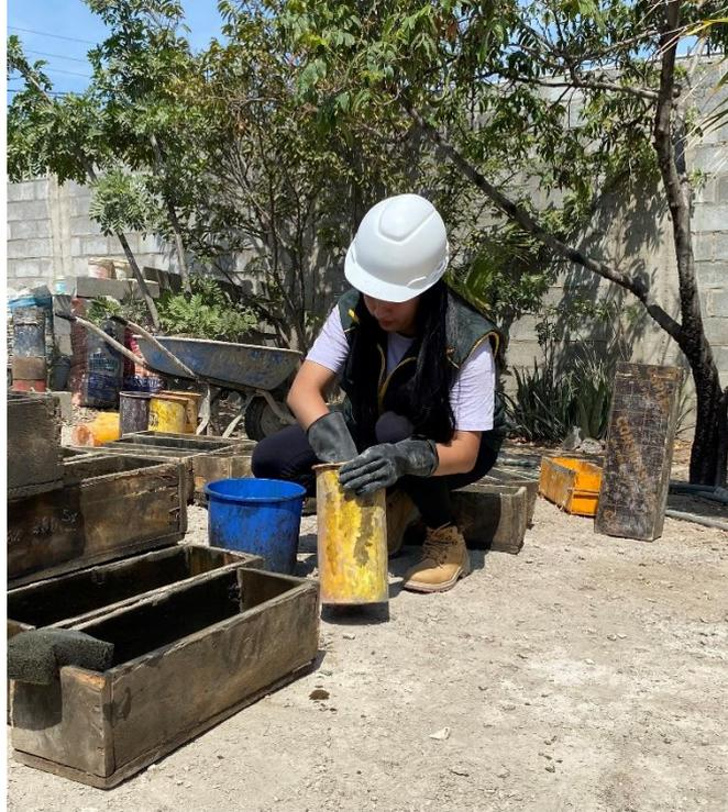
**Fig. 23.** Aplicación de aceite quemado en moldes.
