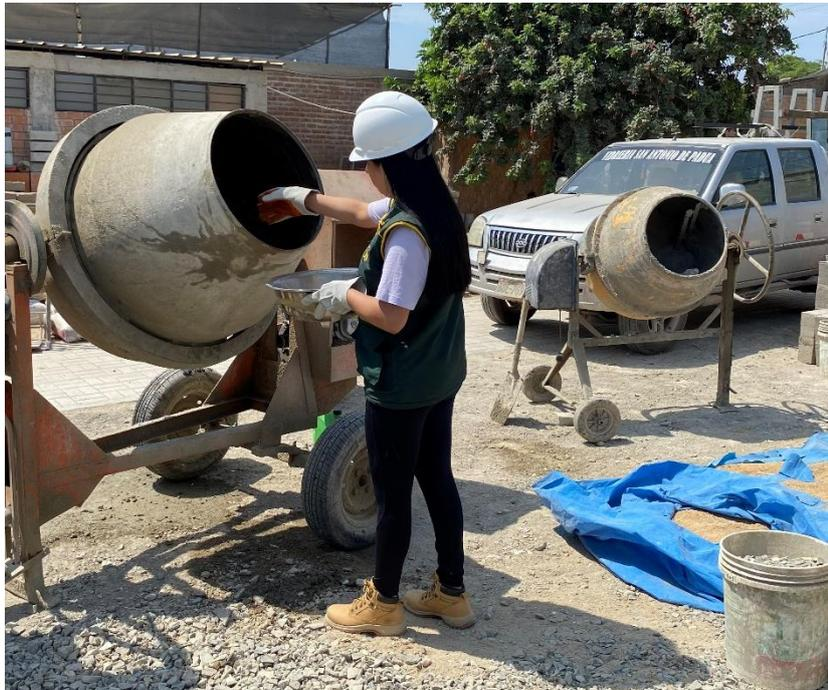
**Fig. 24.** Mezcla de concreto adicionando 0.5% de fibra de estopa de coco.
