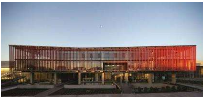
Figura 02: vista de fachada de centro de Producción e Investigación Carozzi
