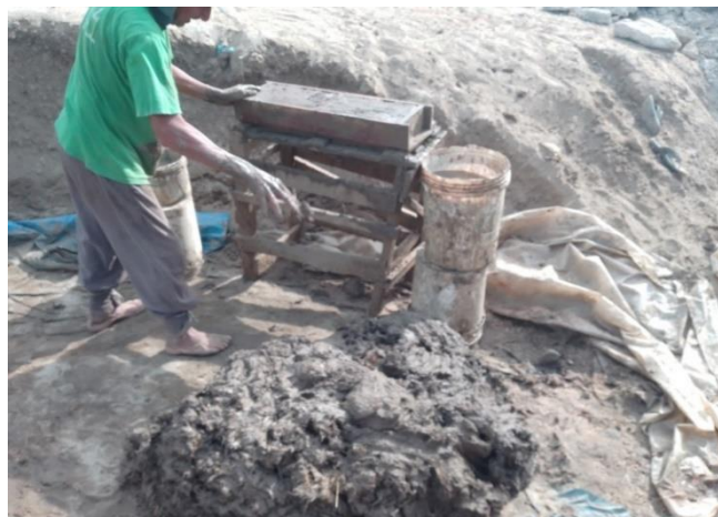
Fig.21. Proceso de moldeado del adobe
