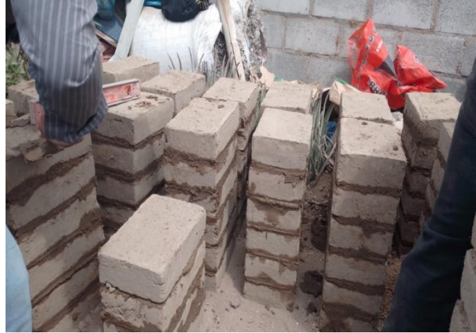
Fig.25. Elaboración de pilas de adobe
