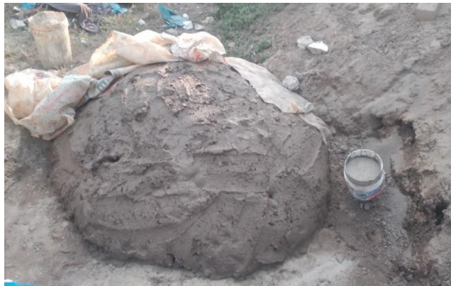
Fig.20. Proceso mezclado de adobe
