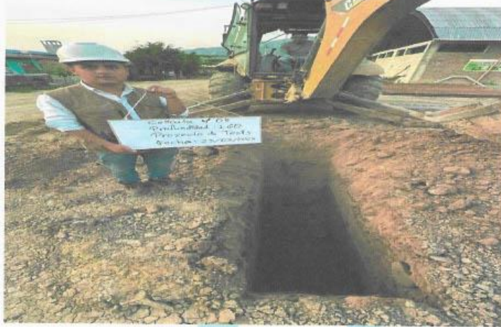
FOTO N°5: CALICATA N°5 UBICADA EN EL KM 22+000 PARA LA TESIS "EFECTO DE LA ENZIMA TERRASIL EN EL MEJORAMIENTO DE UN SUELO CON FINES DE CARRETERA".
