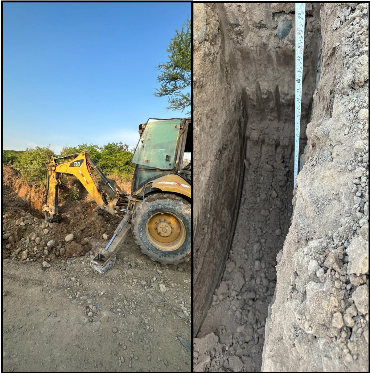
Figura : Excavación de Calicata 4 y verificación de profundidad
