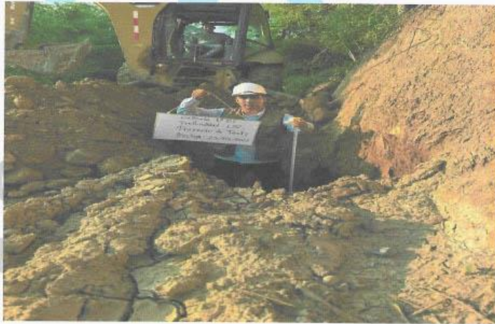
FOTO N°2: CALICATA N°2 UBICADA EN EL KM 19+000 PARA LA TESIS "EFECTO DE LA ENZIMA TERRASIL EN EL MEJORAMIENTO DE UN SUELO CON FINES DE CARRETERA".
