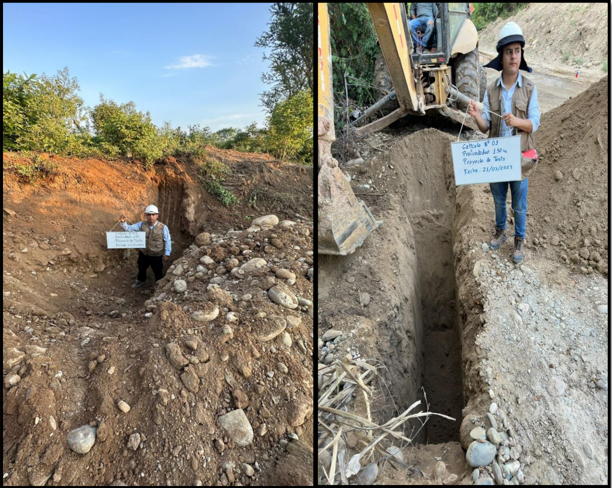
Figura : Excavación de Calicata 03 y 01
