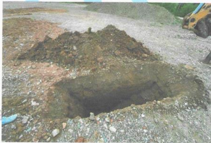
FOTO N°4: CALICATA N°4 UBICADA EN EL KM 21+000 PARA LA TESIS "EFECTO DE LA ENZIMA TERRASIL EN EL MEJORAMIENTO DE UN SUELO CON FINES DE CARRETERA".
