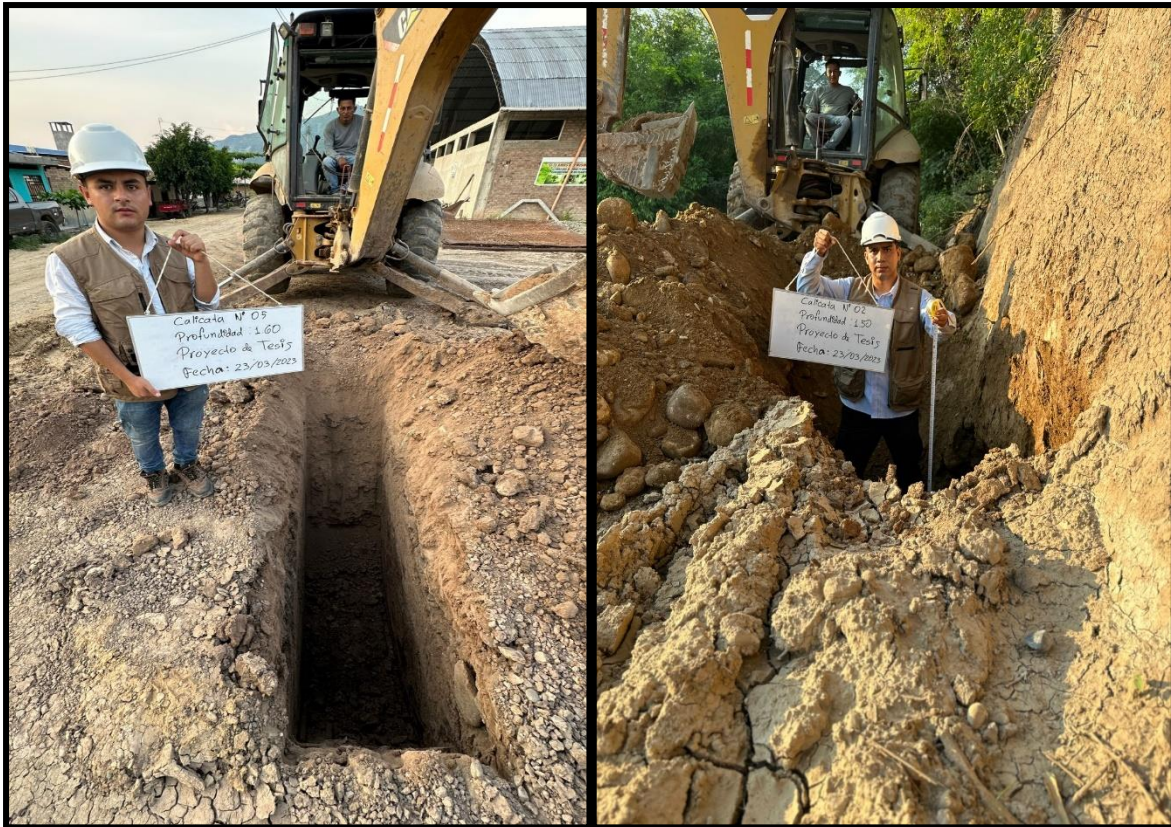
Figura : Excavación de Calicata 05 y 02
