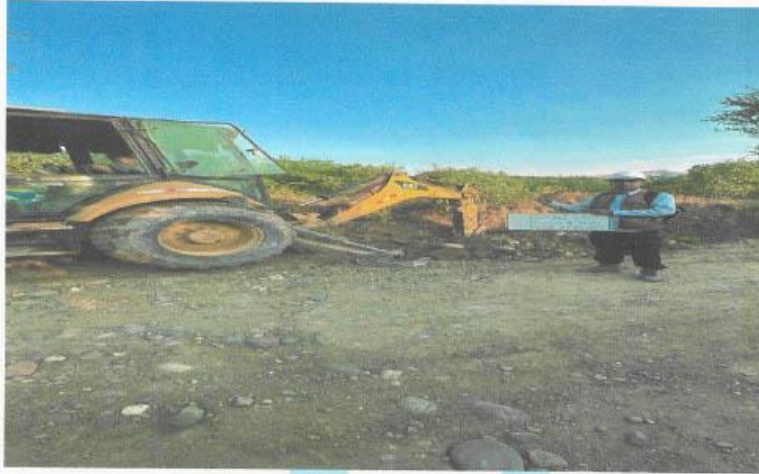
FOTO N°3: CALICATA N°3 UBICADA EN EL KM 20+000 PARA LA TESIS "EFECTO DE LA ENZIMA TERRASIL EN EL MEJORAMIENTO DE UN SUELO CON FINES DE CARRETERA".
