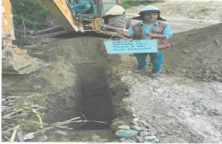
FOTO N°1: CALICATA N°1 UBICADA EN EL KM 18+000 PARA LA TESIS "EFECTO DE LA ENZIMA TERRASIL EN EL MEJORAMIENTO DE UN SUELO CON FINES DE CARRETERA".
