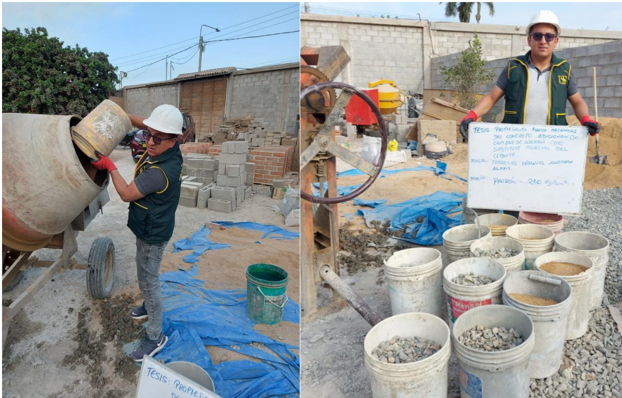
Fig. 51. Realización de la mezcla de concreto con cenizas de aserrín.
