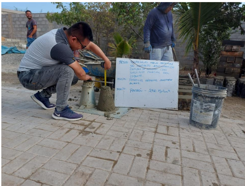
Fig. 52. Ensayo de consistencia del concreto en su estado fresco.
