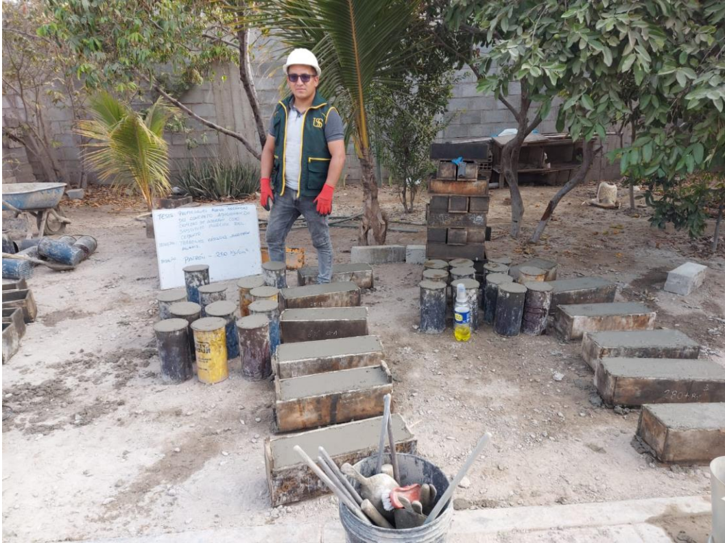
Fig. 55. Vaciado de probetas y vigas.
