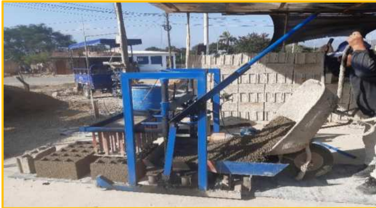
Mezcla en la máquina vibrocompactadora para la elaboración de bloques de concreto tipo P.
