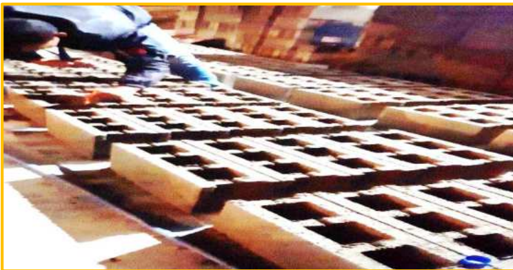
Producción de bloques de concreto tipo P.
