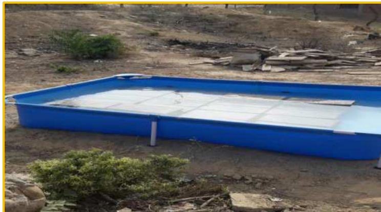
Curado de los bloques de concreto tipo P.
