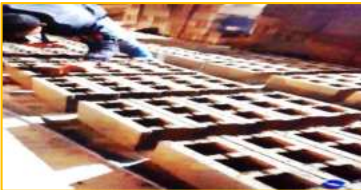
Producción de bloques de concreto tipo P.
