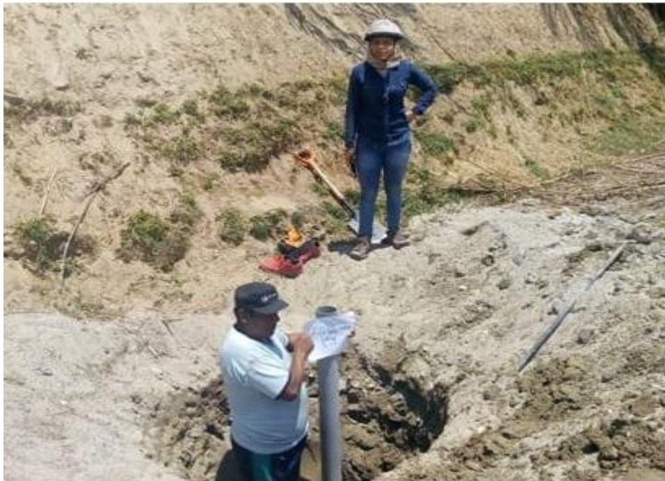
Se realizó la excavación de las calicatas para la extracción de las muestras.
