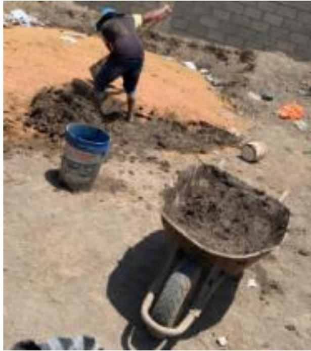
**Fig.30.** Ejecución de mezclado y fabricación de los adobes.
