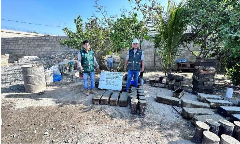
**Fig. 27.** Vaciado de probetas y vigas
