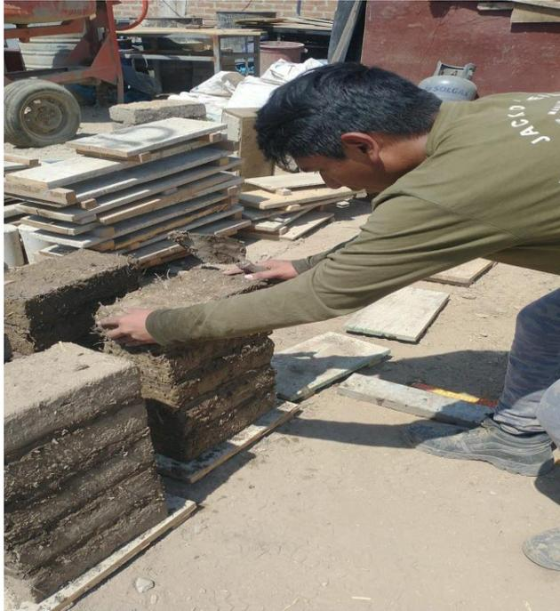
**Fig. 54.** Asentamiento del Bloque de Adobe en los Prismas.
