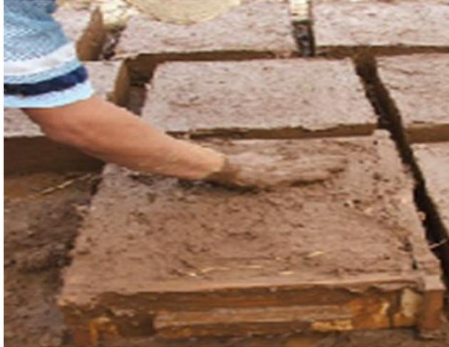
**Fig.9.** Encofrado de la mezcla. [37]
