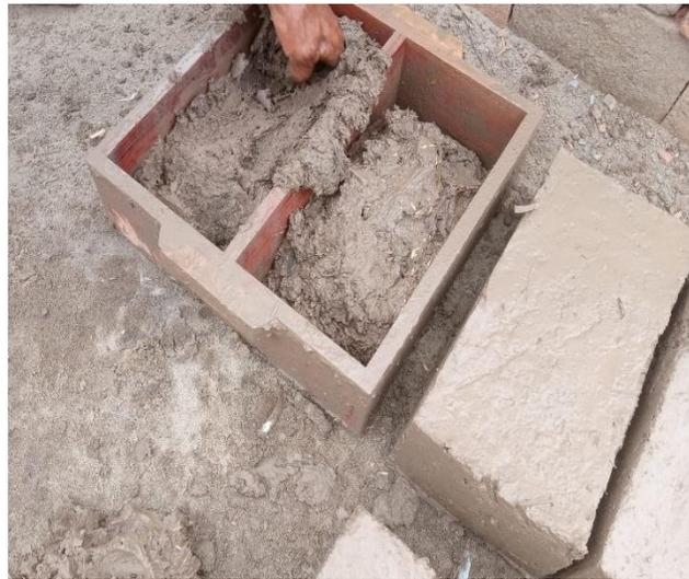
**Fig. 28.** Encofrado del Adobe
