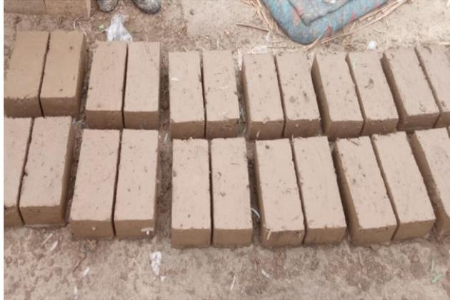
**Fig. 29.** Desencofrado del Adobe
