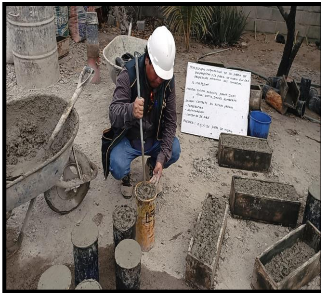
Fig. 29. Apisonado de los moldes de concreto con una varilla
