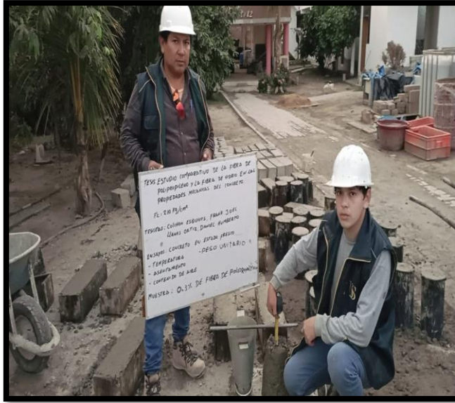
Fig. 30. Ensayo de asentamiento del concreto fresco
