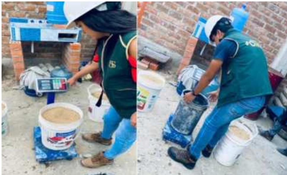
**Fotografía 8:** Pesaje de agregado para el diseño de mezcla
