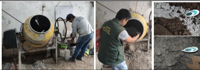
Foto N°31: Luego de haber pesado los materiales se colocan al trompo para su mezclado y se toma la temperatura de la mezcla con un termómetro (NTP 339.184 / ASTM C-1064).
