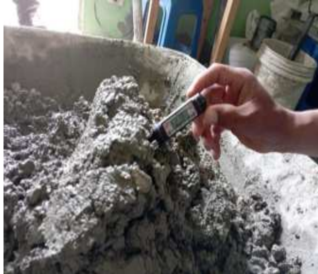
Fig. 14. Medición de la Temperatura del concreto.
