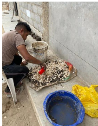
Fig. 44. Fibra de bagazo de caña de azúcar mezclando con el barro según el porcentaje.
