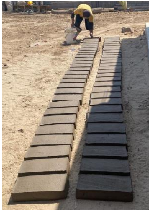
Imagen 7. Fabricación de los adobes convencionales.
