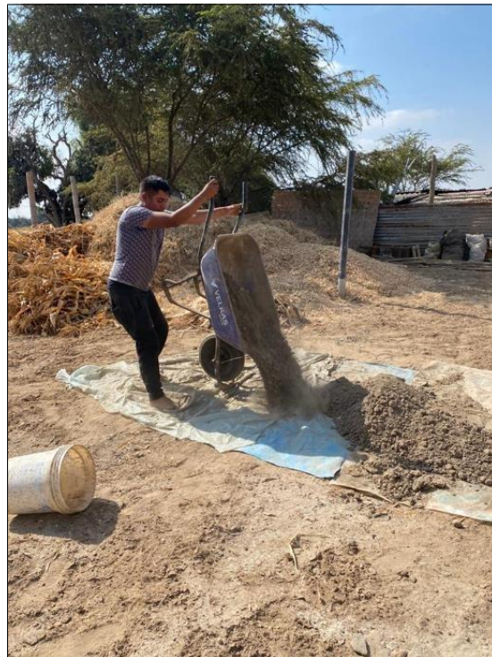
Fig. 38. Extraer y preparar la tierra en una manta para que no se mezcle con la tierra salitrosa cierta cantidad.
