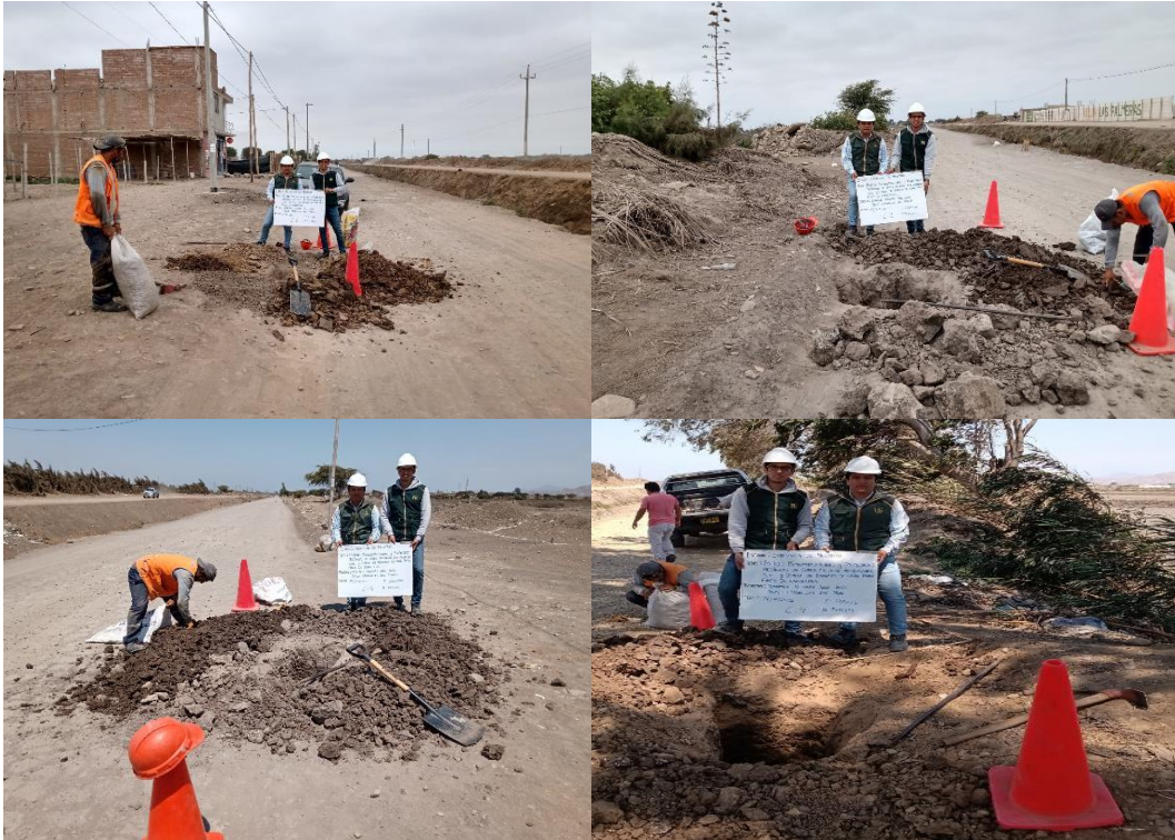
Imagen 1: Extracción de muestras de las 4 calicatas
