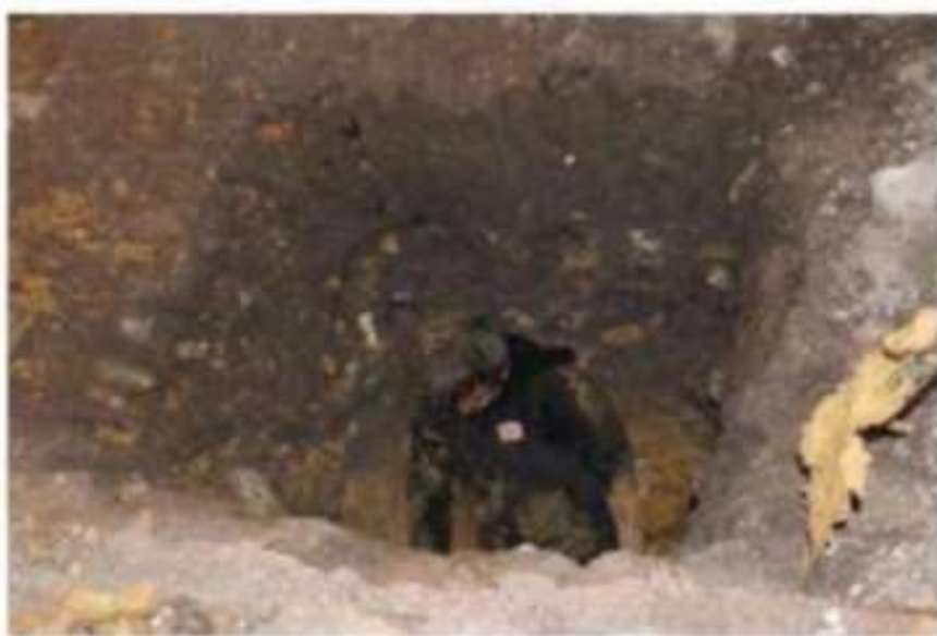
Foto N° 04 – Excavación de Calicata
