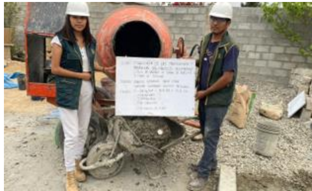
Fig. 24. Ensayo de temperatura - concreto fresco.
