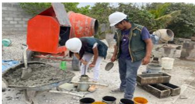
Fig. 23. Slump para determinar el asentamiento del concreto.
