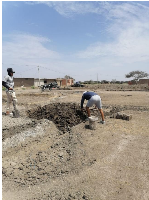
Suelo del lugar donde se extrajo para la elaboración de los adobes.
