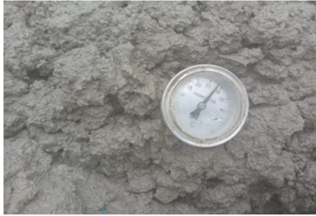
Fig. 15. Ensayo de Temperatura del Concreto
