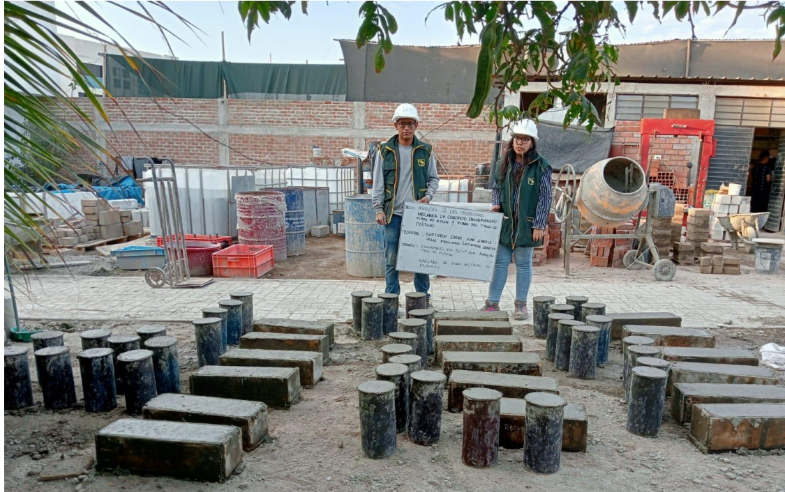
Fig. 37. Vaciado de Probetas y Vigas
