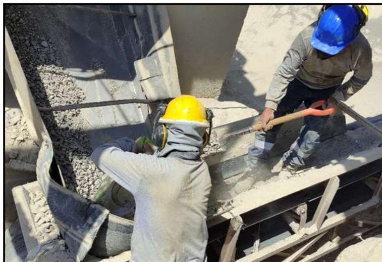
**Fig. 18.** Recolección del material que paso por la trituradora
