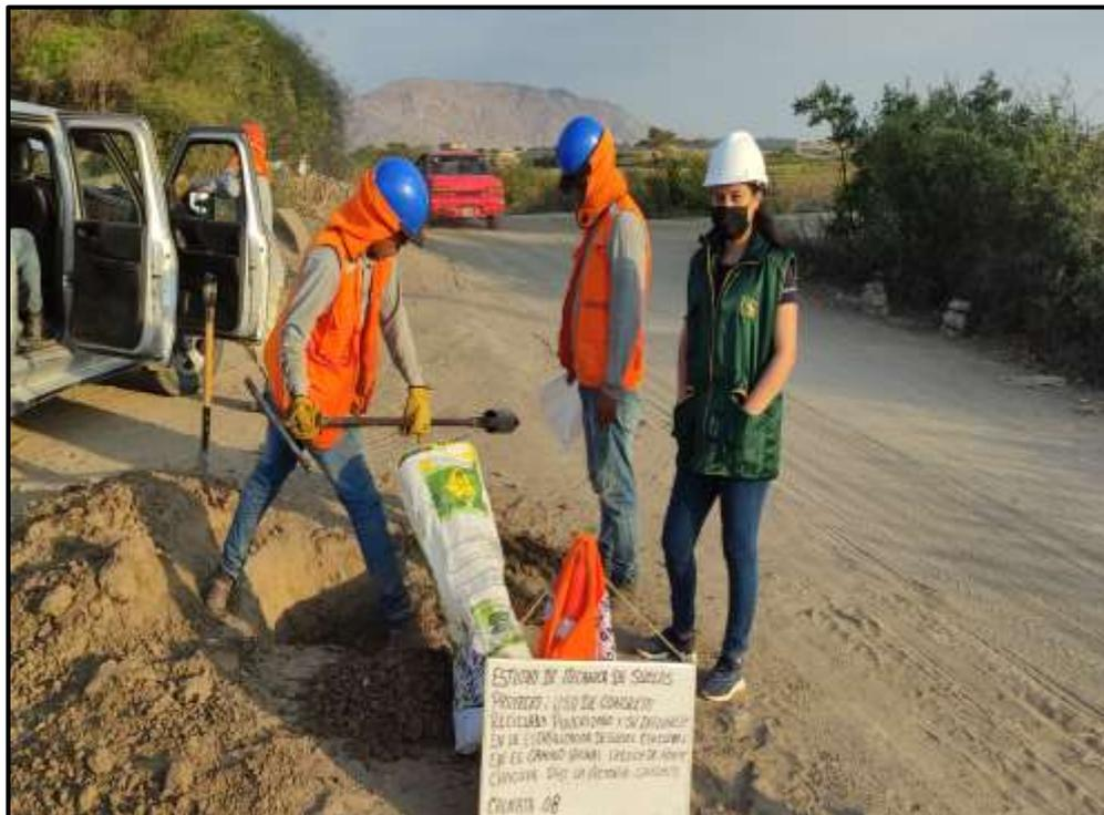
Ilustración 1. Calicatas para obtención de la muestra de suelo.
