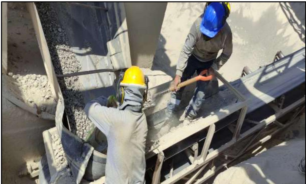
**Ilustración 8. Obtención de la muestra pasada por la pulverizadora en la cantera PIEDRA AZUL**
