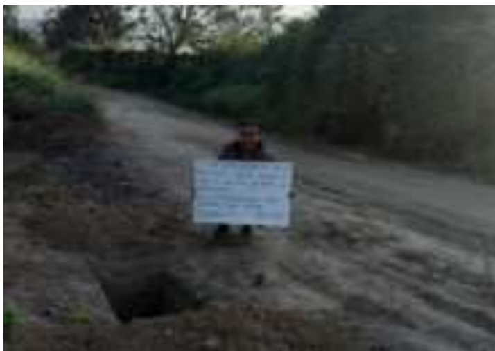
Fig. 11. Obtención de muestras de suelo natural camino vecinal "Cercos Quemados" C – 02.
