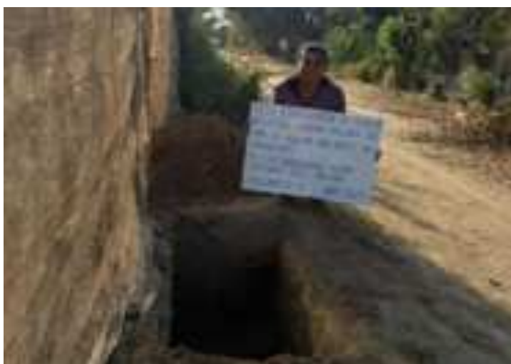
Fig. 13. Obtención de muestras de suelo natural camino vecinal "Cercos Quemados" C – 04.
