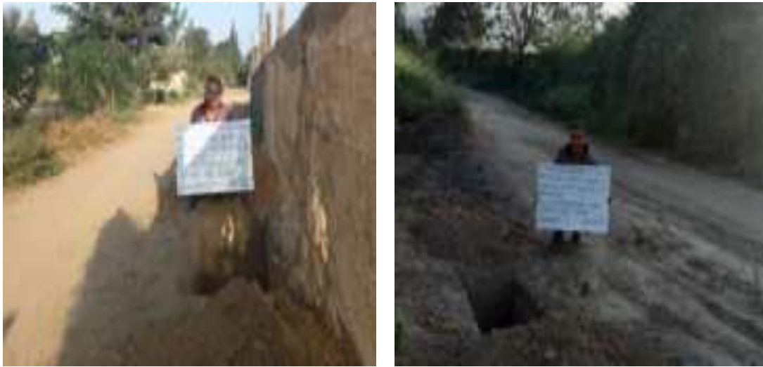
Fig. 32. Obtención de muestras de la calicata 01 y 02
