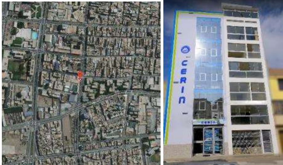
Figura 1: Ubicación y fachada del edificio principal de la Clínica CERIN
